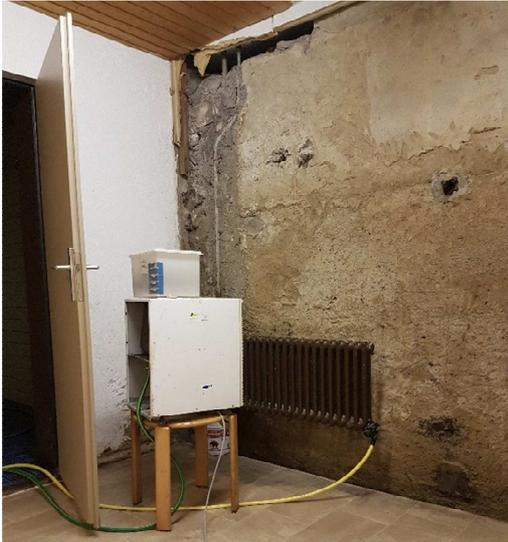
Danach entleerten wir das ganze Heizsystem bevor sich das nun relativ ungebremste Wasser im ganzen Untergeschoss ausbreitete. In der darauf folgenden Woche legten die Arbeiter von der Firma Hirzel die neue Leitung. Ein neuer Radiator liegt bereit. Sobald die Wand völlig ausgetrocknet ist, wird die Renovation abgeschlossen.
